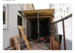
Schon nach 2 Tagen war die Mauerbrüstung abgetragen und es wurde mit dem Fenstereinbau auf der Empore begonnen. Daneben wurde im Vorraum die Zwischentür demontiert und der alte Steinboden herausgestemmt.
